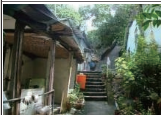
柑林段815地號之磚造房屋
