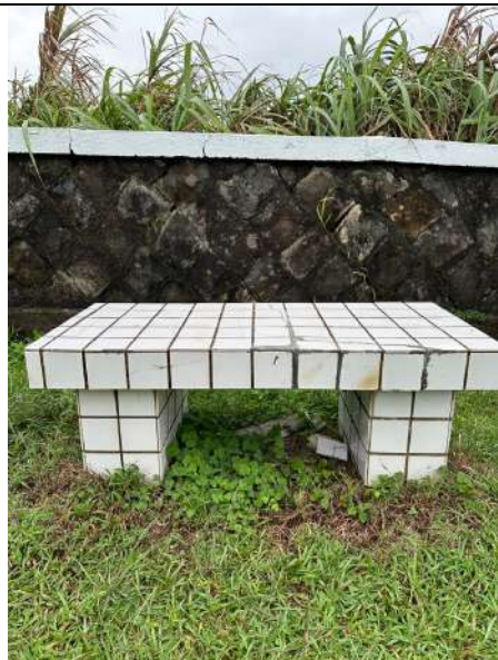
園區戶外草坪區的座椅下方需要更確實清除垃圾與雜物
