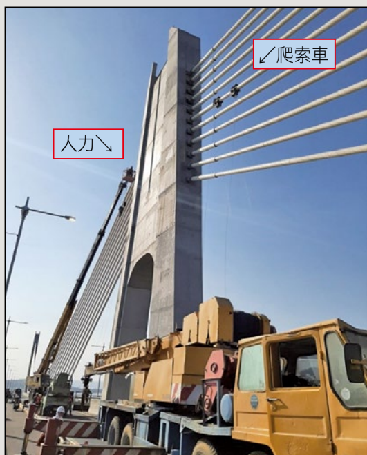
圖1 現地使用舉高車與爬索車作業之明顯對比
