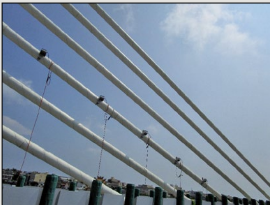
圖2 五顆感測計於鋼纜布設實景
