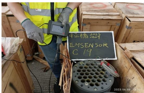
圖6 中正橋鋼纜索力監測系統建置
