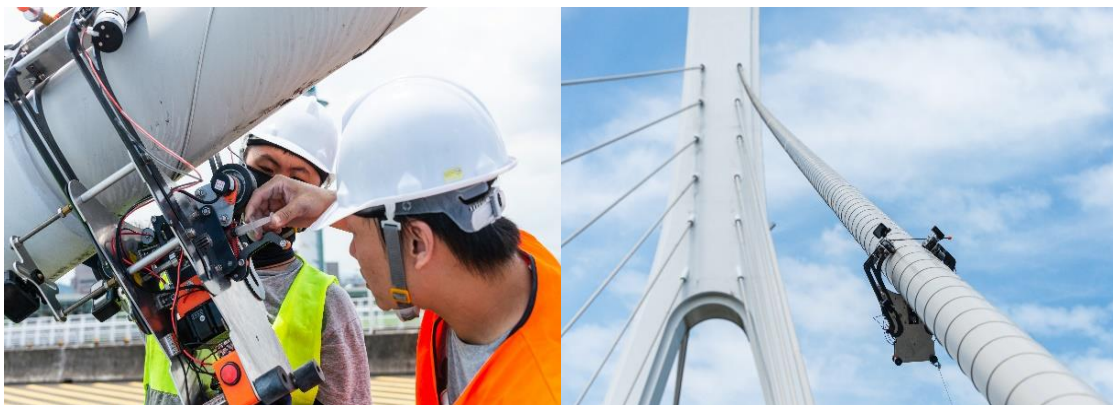
圖13 現場安裝及爬升測試
