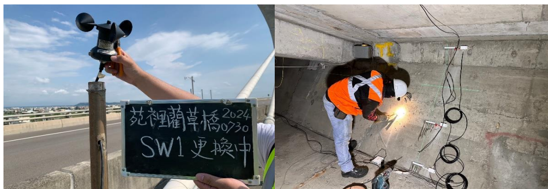
圖8 風速計更新與無線動態應變計安裝
