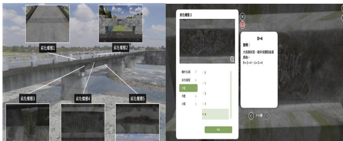
圖22 3D 場景橋梁構件與劣化損傷
