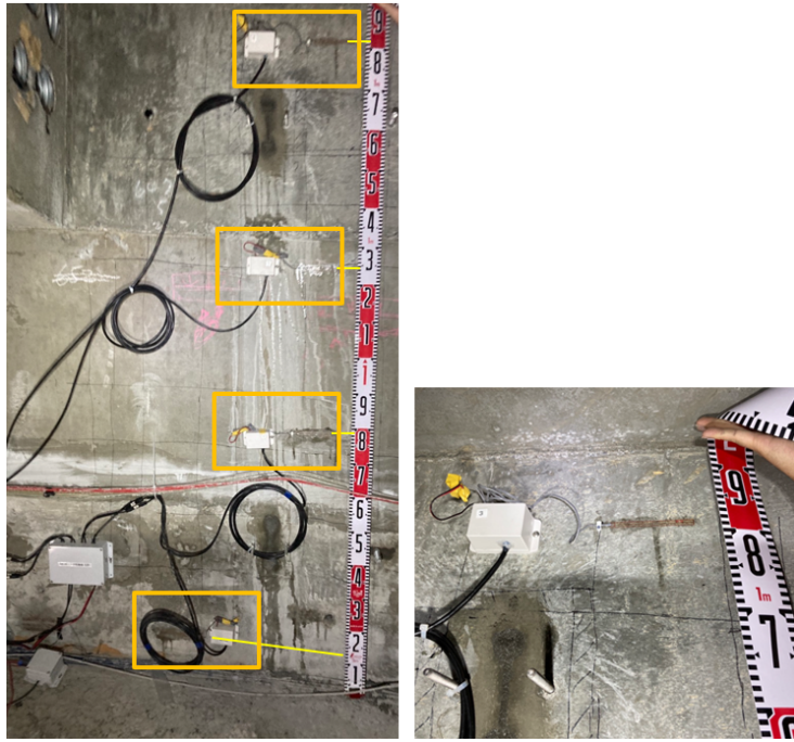
圖 5 石灼高架橋(PE4-PE5) 4 通道斷面中性軸位置監測儀器之安裝
